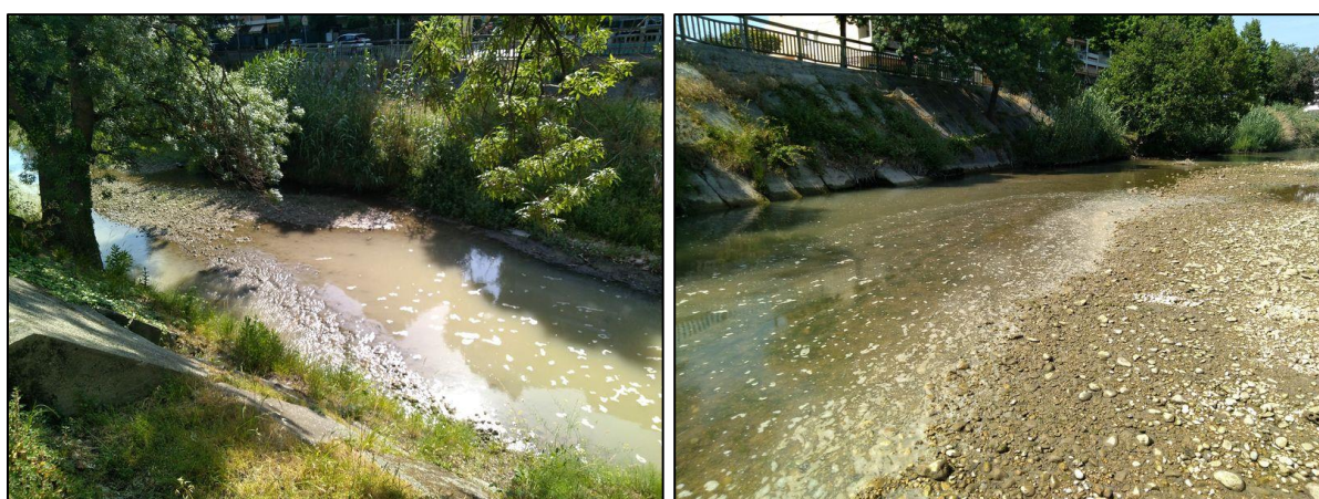
Figure 17 : Impacts causés par les travaux sur la zone d'étude, laquelle est située en aval.
