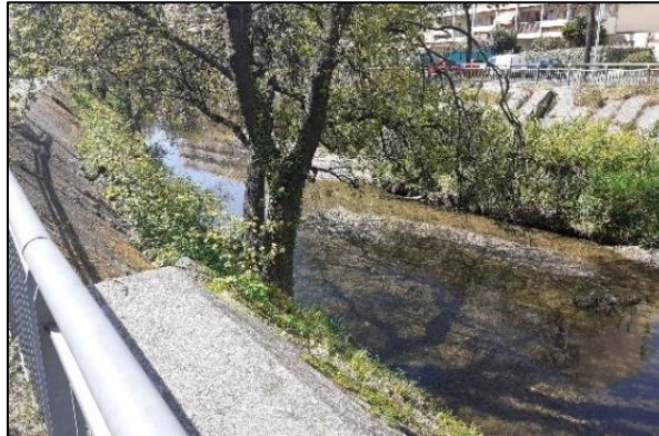
Figure 13 : Photos des berges recouvertes par la végétation (Source : SEGED 04/04/2022)
