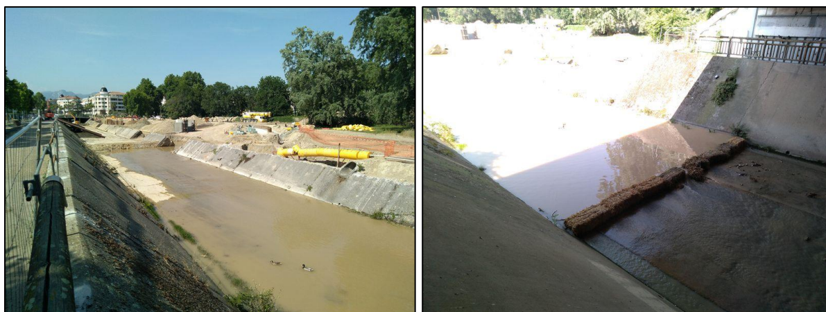
Figure 16 : Travaux effectués en amont de la zone d'étude.
