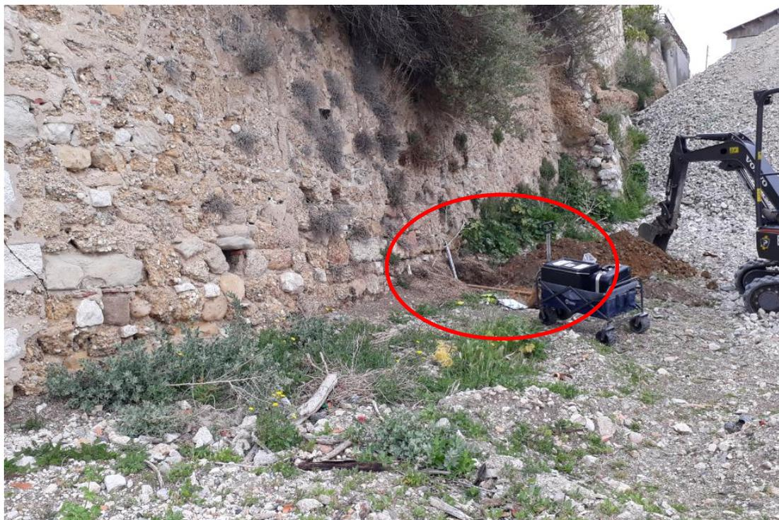
Cette reconnaissance révèle un mur en moellons de poudingues, avec une assise vers 0,90 m de profondeur, au toit du substratum compact.
