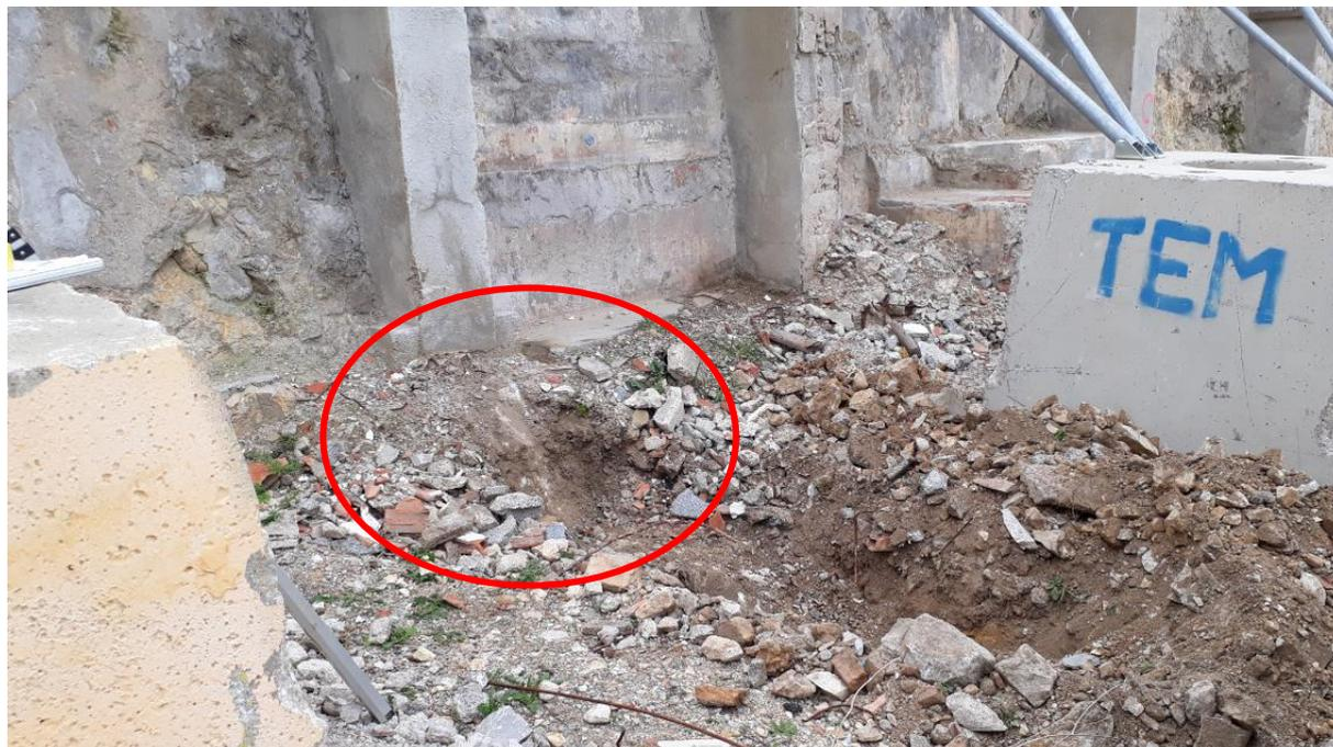
Cette reconnaissance révèle une assise à faible profondeur, sur des formations calcaires ou bréchiques (substratum local, visible également à l'affleurement à proximité immédiate – cf photo page suivante).
