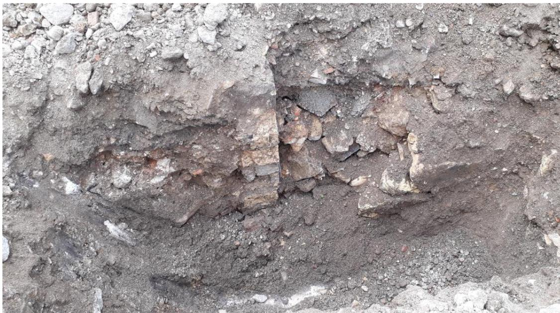
Compte tenu de la forme très graveleuse de ces remblais, avec présence de nombreux blocs, la réalisation de certains essais en laboratoire (essais Proctor notamment) s'est avérée impossible.
