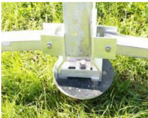
**Platine d'une vis d'ancrage**
