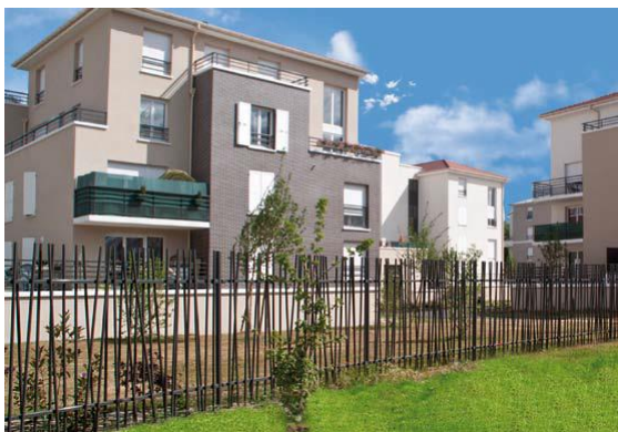
Type de clôture + garde-corps Normaclo Obambo ou Orosoo (surmonté d'un mur bahut en pierre calcaire)
