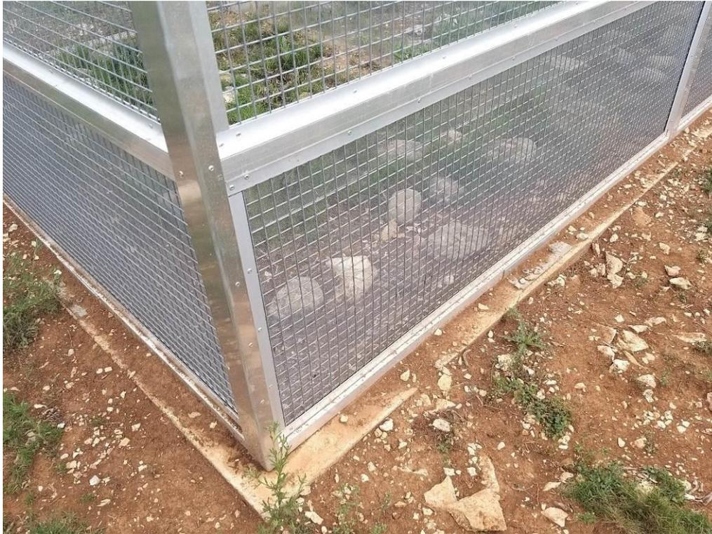
Figure 17. Fondation en béton. Bande en béton, largeur 15 cm, profondeur environ 50 cm.
