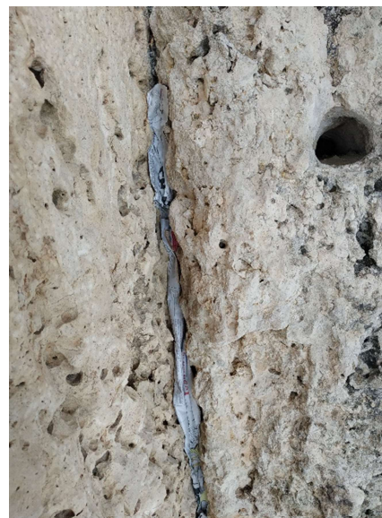
Joints dégradés obturés à l'aide de journal et de papiers.
