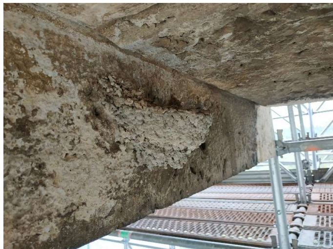
Nid d'Hirondelles de rochers sous la voûte de la travée 3.
