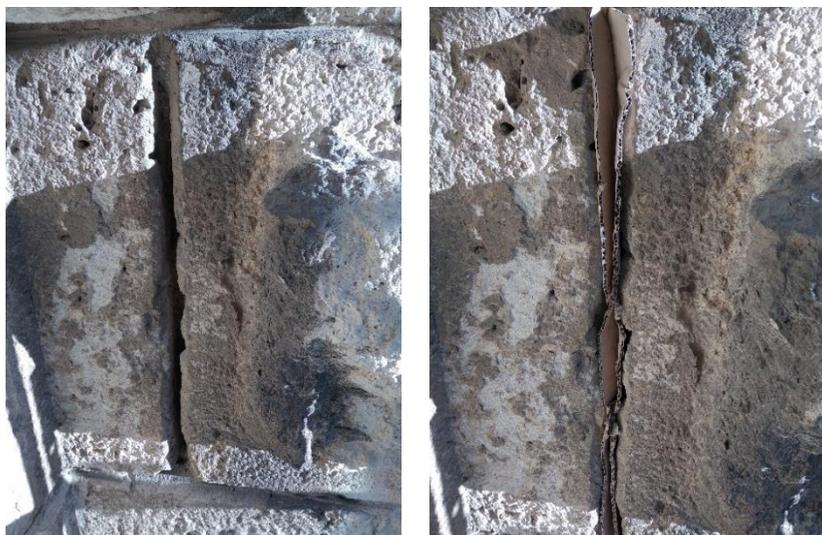
**Joint dégradé potentiellement favorable aux chiroptères, obturé à l'aide de carton, avant et après obturation.**
