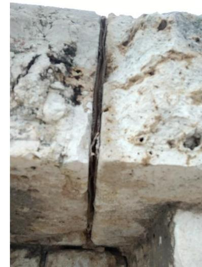
**Joint dégradé potentiellement favorable aux chiroptères, obturé à l'aide de carton, avant et après obturation.**
