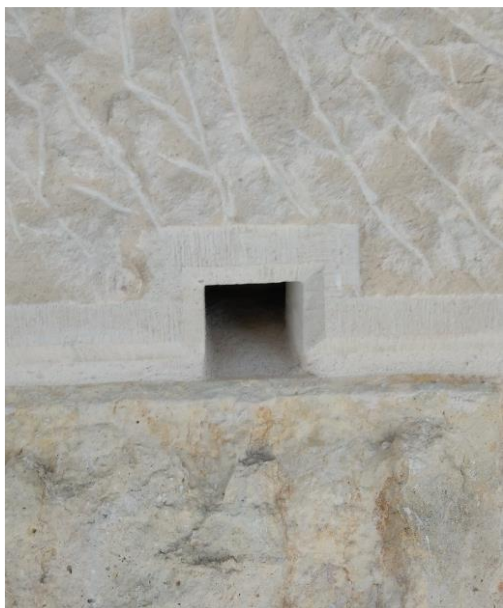
Création d'un gîte chambre au niveau d'une pierre remplacée sur la pile 5
