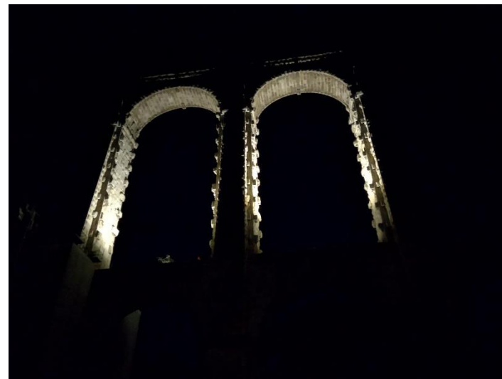
Eclairage des voûtes avec le nouveau système de projecteurs à casquettes
