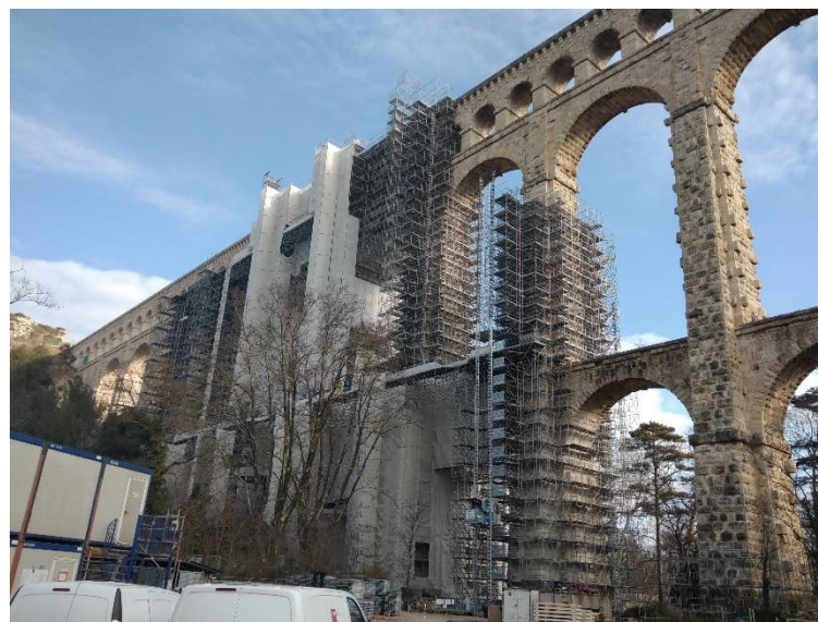
Etat du chantier en janvier (haut) puis en décembre 2021 (bas)
