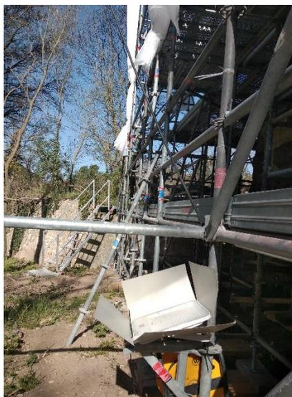
L'audit de chantier réalisé le 14/04/2022 concernait la recherche et le contrôle de la présence/absence de chiroptères dans l'ensemble des fissures/cavités de la partie inférieure de la pile 11, préalable à leur obturation et à la fermeture de l'échafaudages par des filets ainsi que le contrôle des éclairages.
