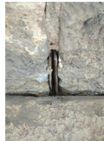
**Joint dégradé où du guano a été observé (à gauche) obturé (à droite)**
