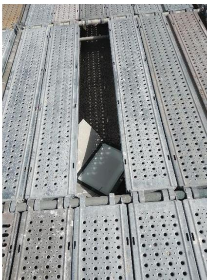
**Emplacement du projecteur non adapté (sous plancher)**
