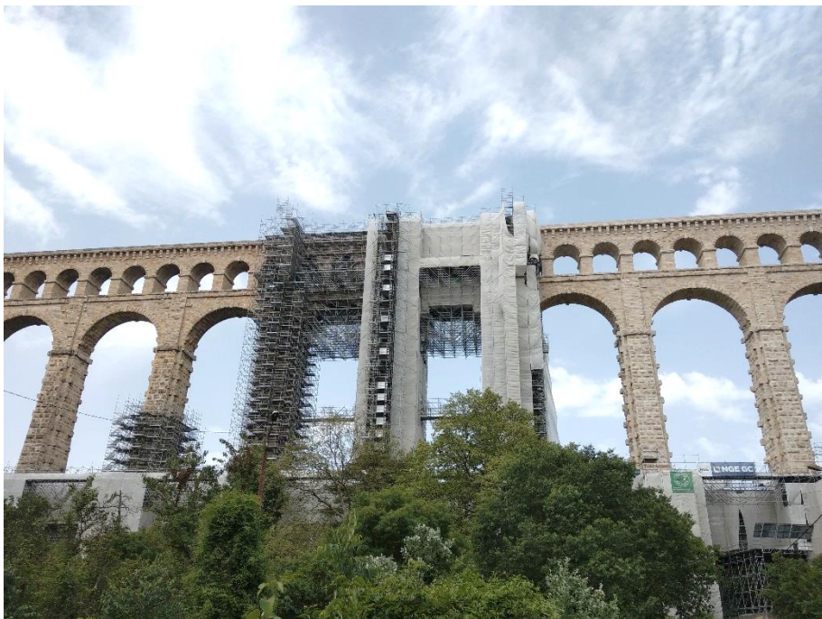
Etat actuel du chantier sur l'ouvrage (vue Est avec pile 9 non bâchée et partie supérieure de la pile 10 en cours d'échafaudage)
