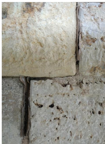
Joint dégradé où du guano a été observé
