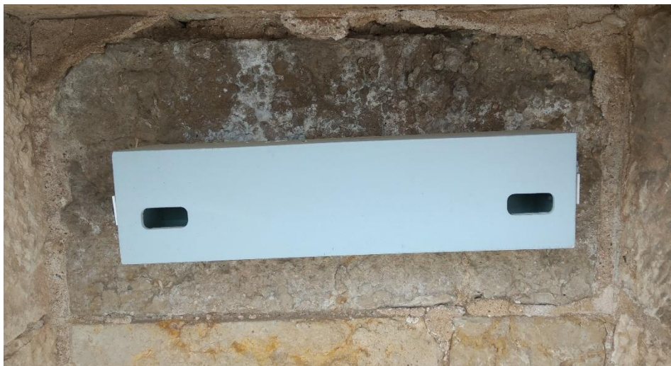
Double nichoir de substitution installé pour le Martinet de noir
