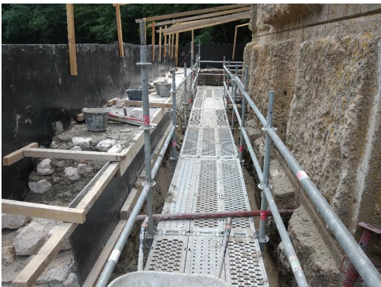
Plateforme créée en pied de pile immergée et reprise de maçonnerie
