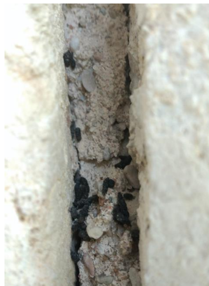
Joint dégradé où du guano a été observé
