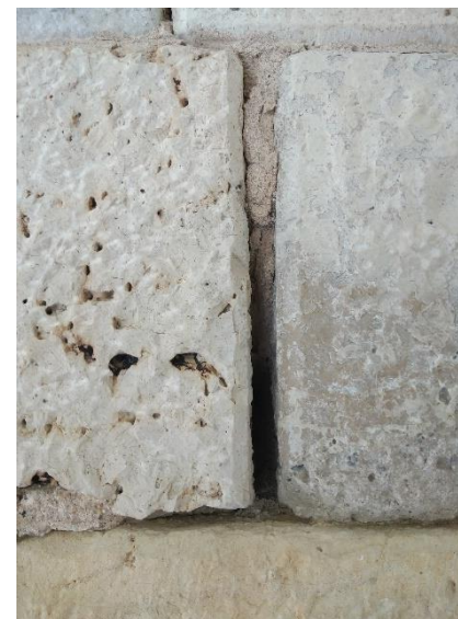
Joint dégradé où du guano a été observé
