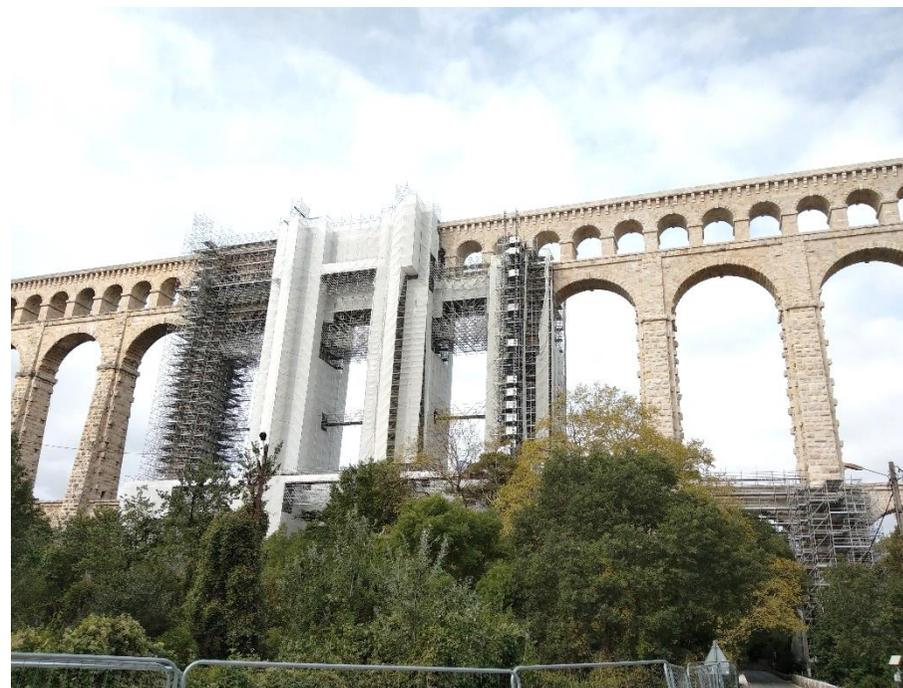
Etat actuel du chantier sur l'ouvrage (vue Est avec pile 11 non bâchée et pile 7 démontée)
