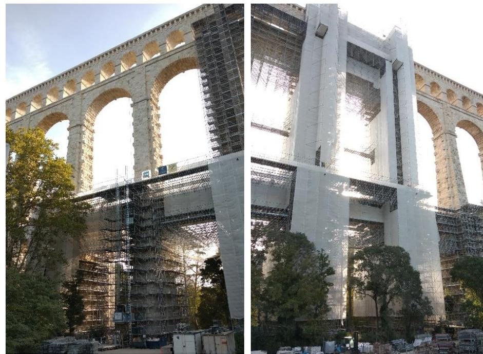
**Etat actuel du chantier sur l'ouvrage : vue Est avec partie supérieure de la pile 8 démontée (photo de gauche) et partie inférieure de la pile 12 montée (photo de droite)**
