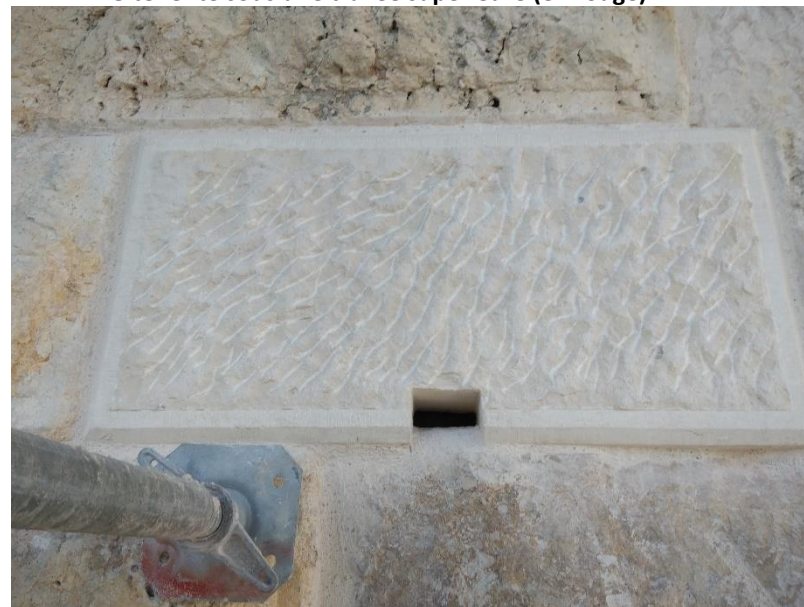
Gîte de type « Chambre » sur la pile 11 (volume disponible derrière la nouvelle pierre)
