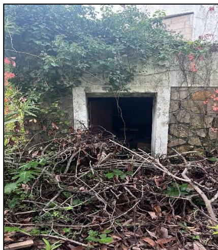
Entrée du sous-sol de la bâtisse principale au sein de la zone d'étude, jugée à enjeu « très faible »
