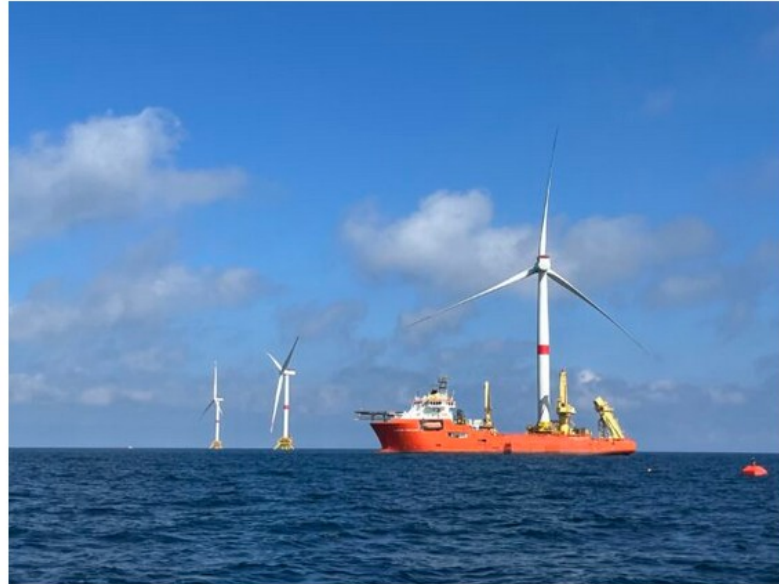
Les trois éoliennes du projet-pilote éolien en mer flottant Provence Grand Large à 17km de Port-Saint-Louis-Du-Rhône – ©EDF Renouvelables
