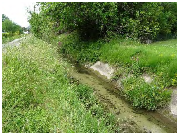
Canal au chemin des Paluds
