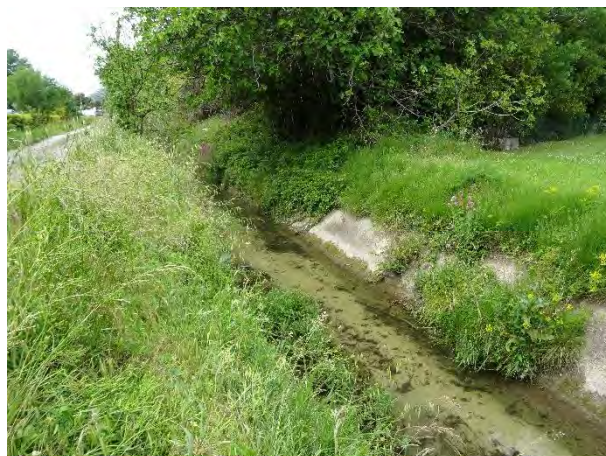
Canal au chemin des Paluds
