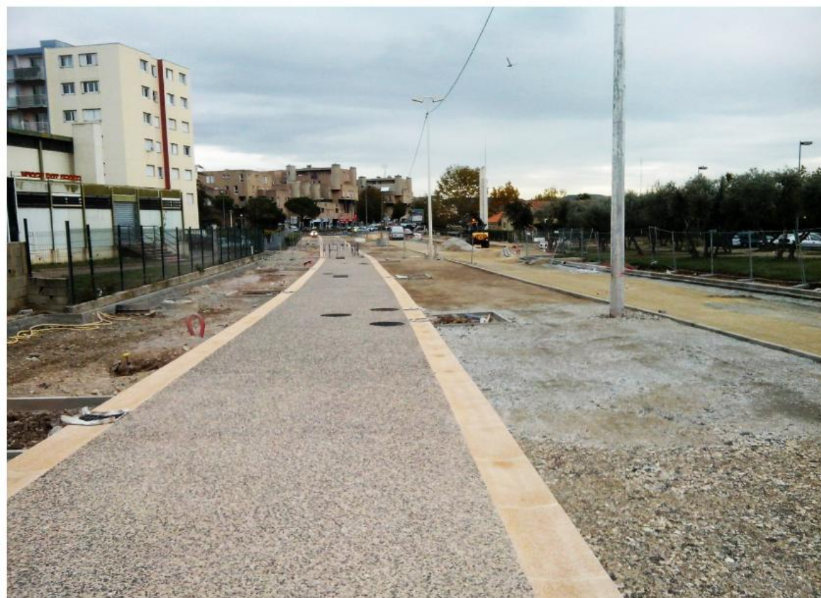
Salyens Sud en cours de travaux
