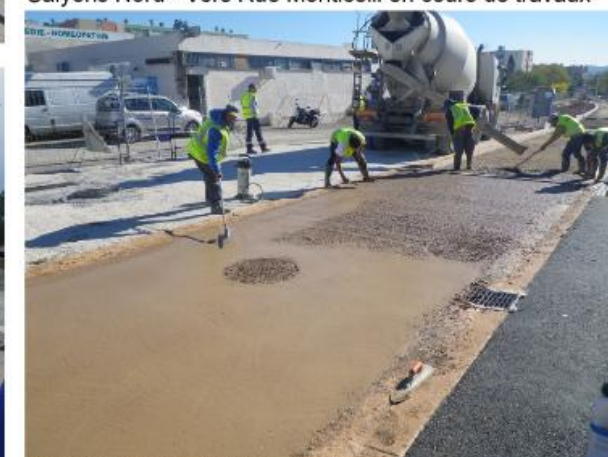
Salyens Sud en cours de travaux
