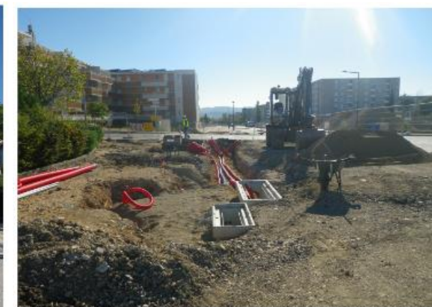
Salyens Nord - Vers Rue Monticelli en cours de travaux
