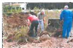
Une fois extraites du sol à la pelle mécanique, les mottes ont été déposées manuellement sur le chargeur du tractopelle, puis transportées jusqu'au camion porteur mis à disposition par la ville de Fréjus le temps de l'opération. Les mottes ont ensuite été déchargées, disposées délicatement et sans entassement (toujours manuellement) sur le plateau du véhicule puis transportées jusqu'au bassin d'orage du Castellans situé 2Km au Nord.
