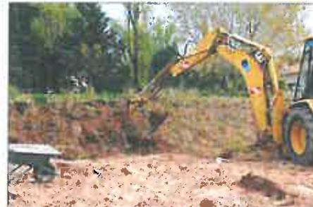
Extraction des mottes au tractopelle muni d'un godet de 30 cm
