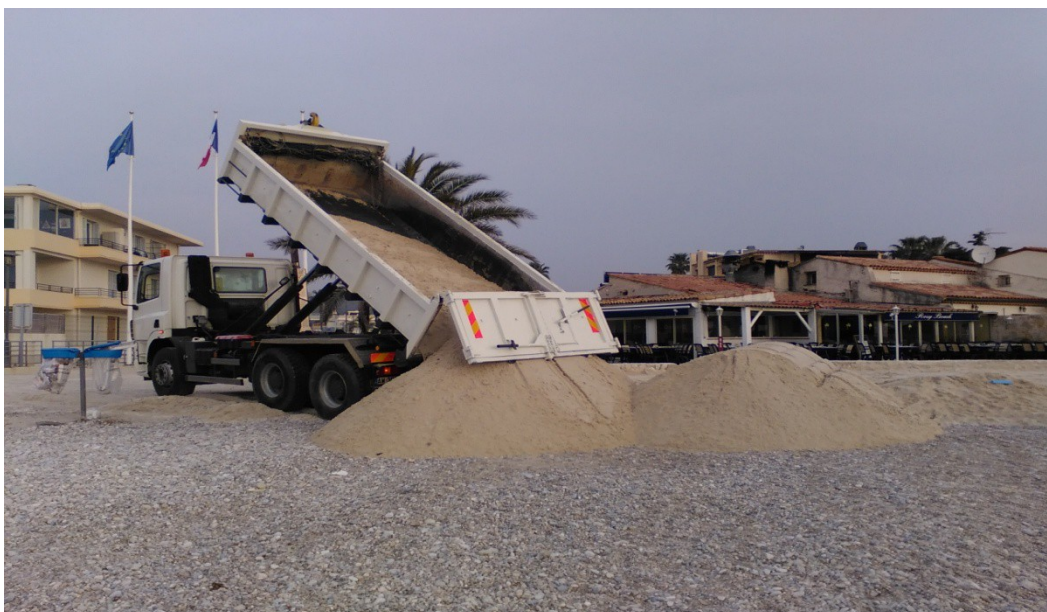
Livraison du sable par les camions
