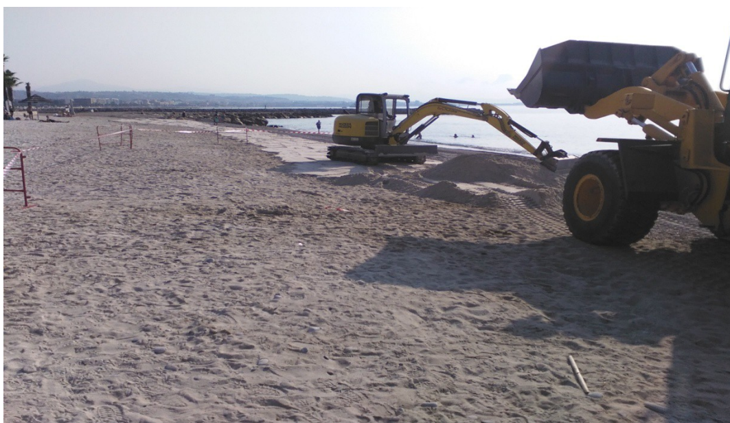
Etalage du sable à l'aide d'engins mécanique avec balisage de chantier
