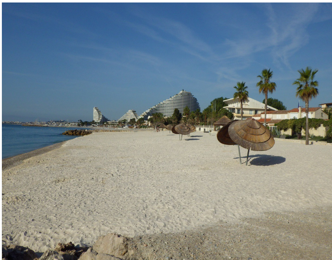
Mise en forme de la plage des Bouches du Loup à sa création en 2014
