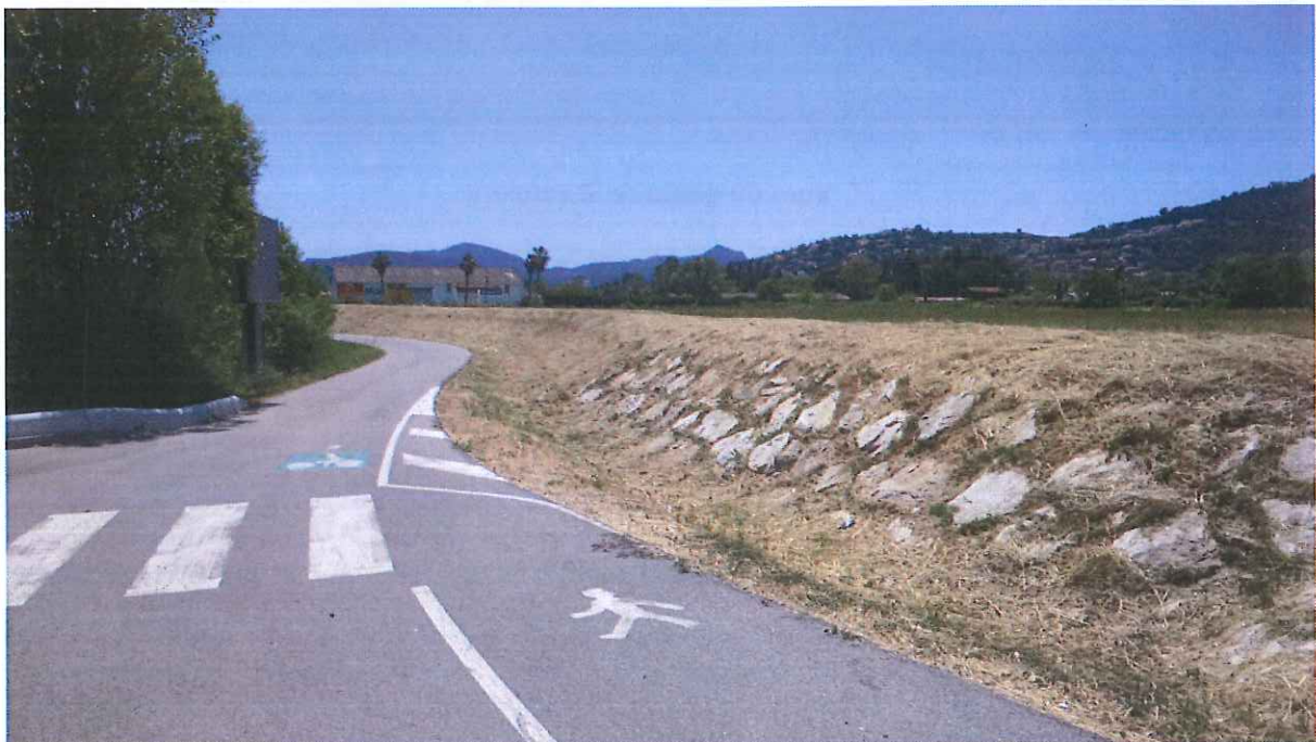
Vue amont de la piste cyclable et de la digue de protection contre les crues
