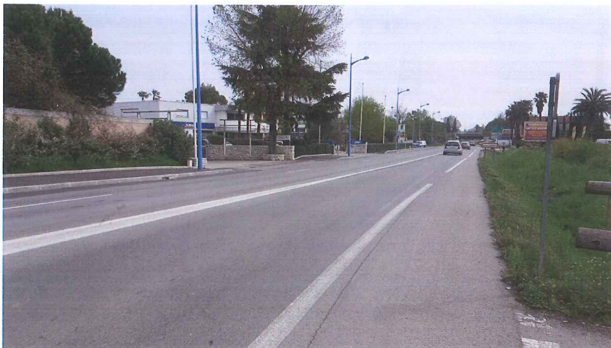
Vues de la RD 6207, rive droite ou coté ouest à aménager
