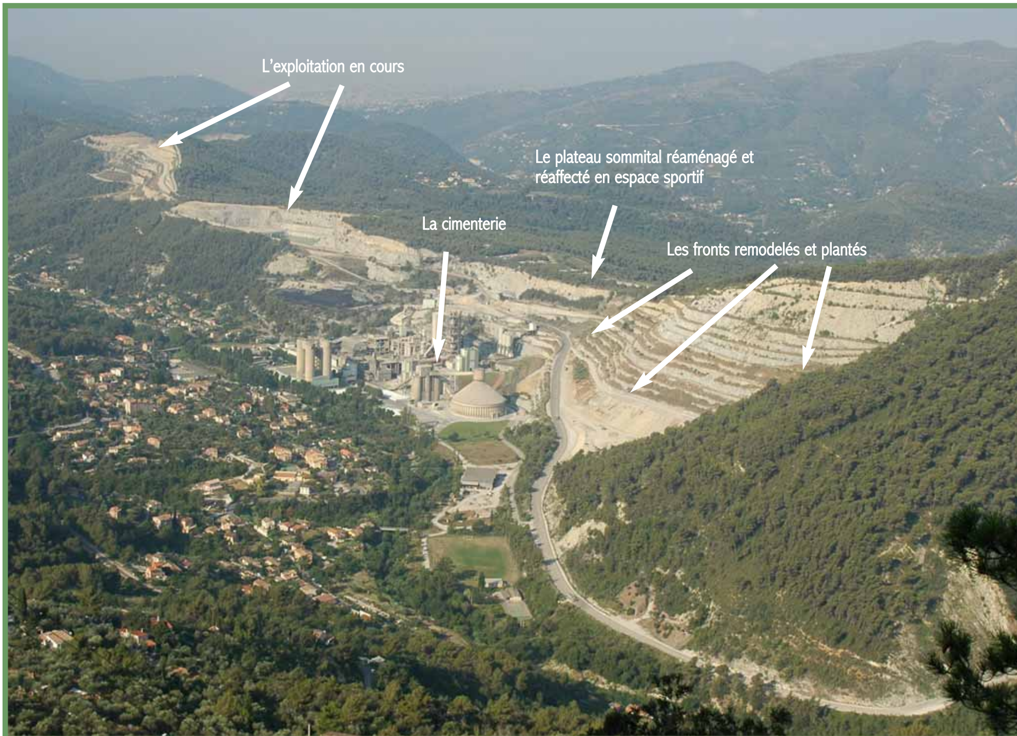
La cimenterie et les carrières Vicat [la Grave-de-Peille (06) - Exploitant : Société Vicat - 2005]
