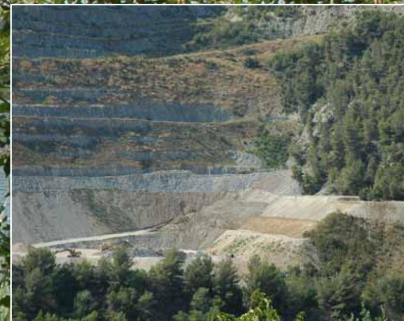
Réaménagement des fronts par rectification des gradins, talutage, végétalisation mettant en oeuvre des techniques innovantes de génie écologique. [La Grave-de-Peille (06) - Exploitant : Société Vicat - 2005]
