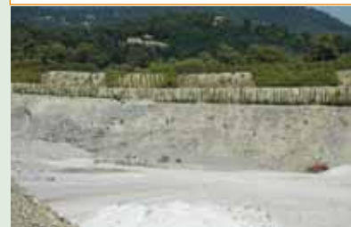
Gradins réaménagés : la géométrie des surfaces plantées, la rigidité des essences affirment le caractère artificiel des gradins. L'harmonie de la recomposition paysagère pourrait être améliorée par une implantation plus souple d'essences locales.
