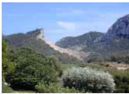
Carrière de grès du Val d'Aren (Le Beausset, Le Castellet, Evenos (83) - Exploitant : Lafarge Granulats du Midi- 2004)
