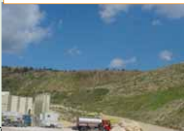
Un apport de matériaux inertes a permis de taluter en versant les pieds des fronts
