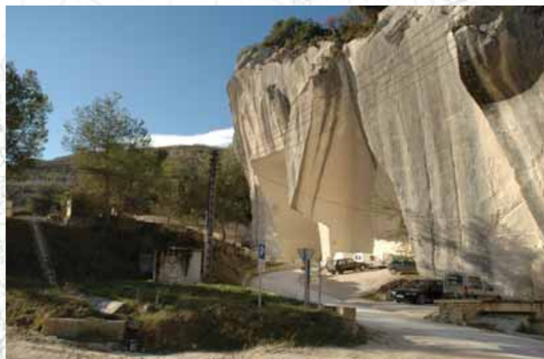
Les entailles des anciennes galeries : entrée de la carrière de pierre de taille des Estaillasses de Blacouve [Oppède (84) - Exploitant : Société Carrières de Provence - 2005]
