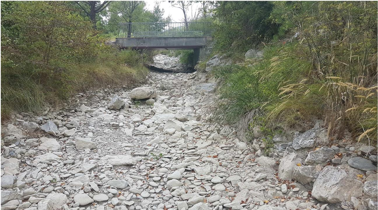
**Photo 12** : Pont sous-dimensionné et lit pavé artificiellement.
