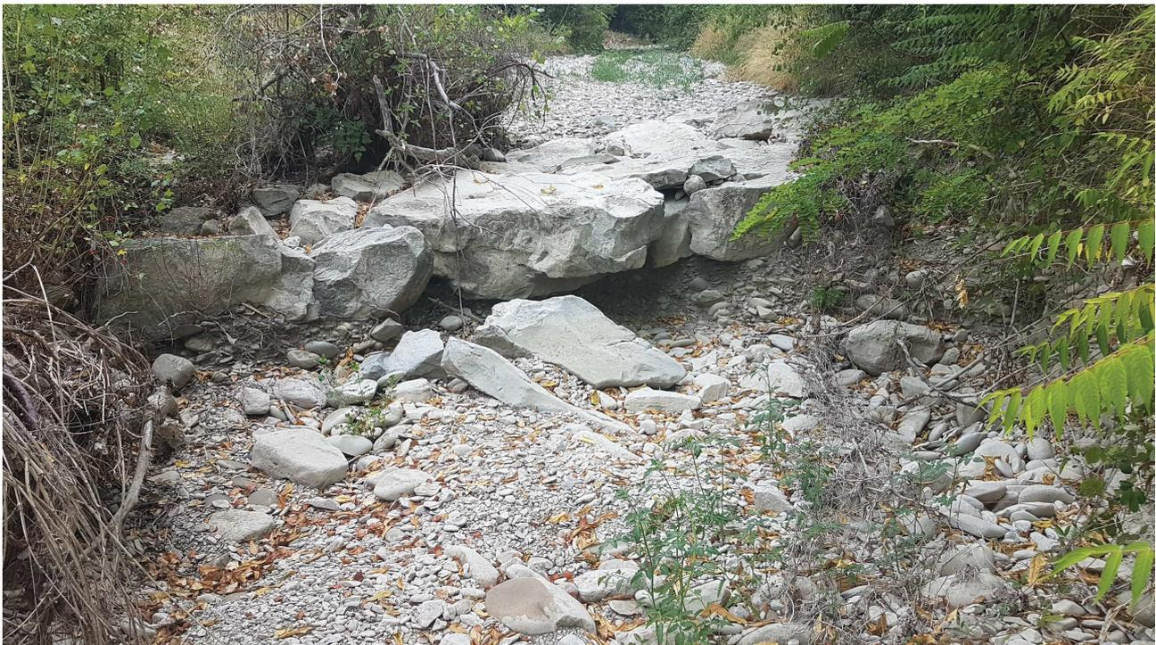
**Photo 11** : Seuil dégradé (conduite de gaz ?).
