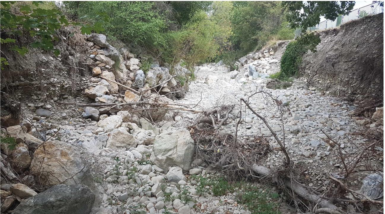
**Photo 14** : Destruction de la protection de berge au droit du lit exagérément rétréci.
