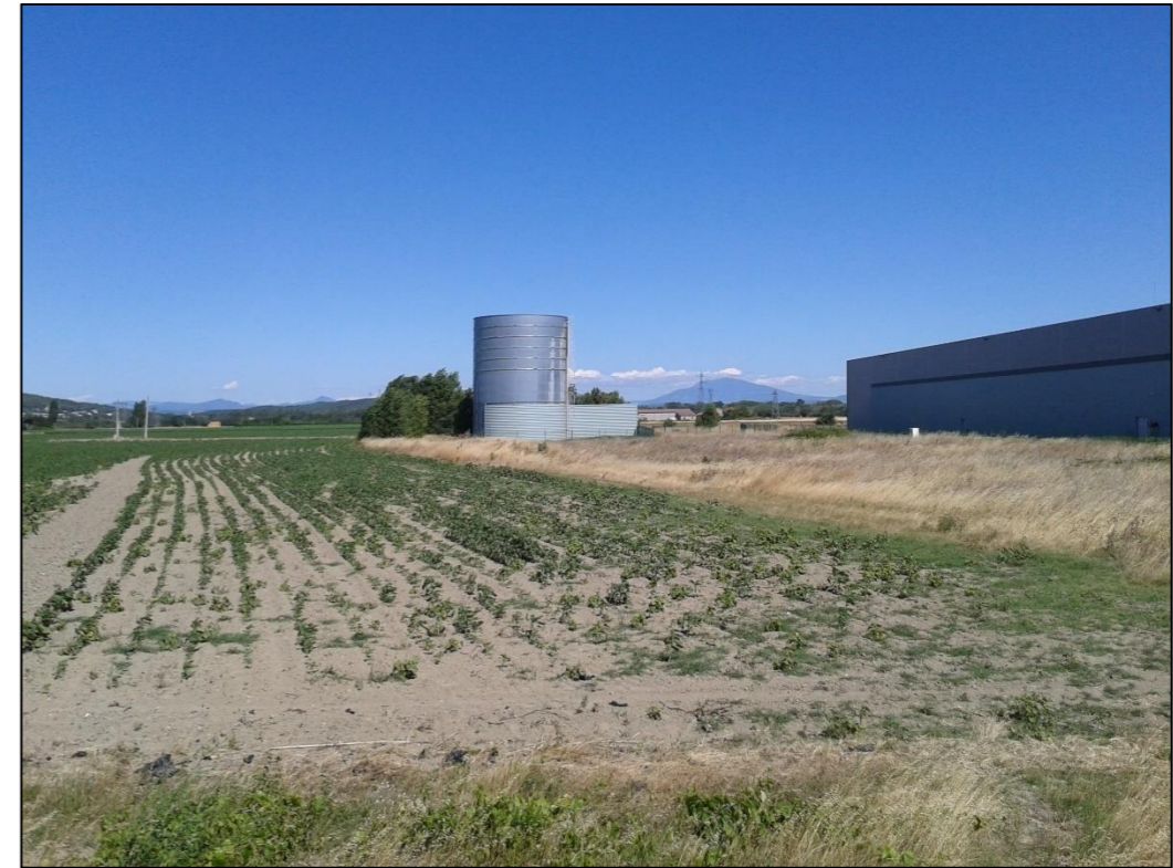
Point de vue n°3 – Vue du site vers les cuves sprinkler
