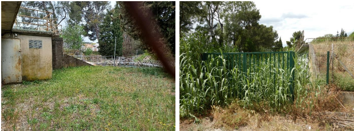
Figure 5 : Prises de vue de la végétation présente aux abords des ouvrages de Noves
