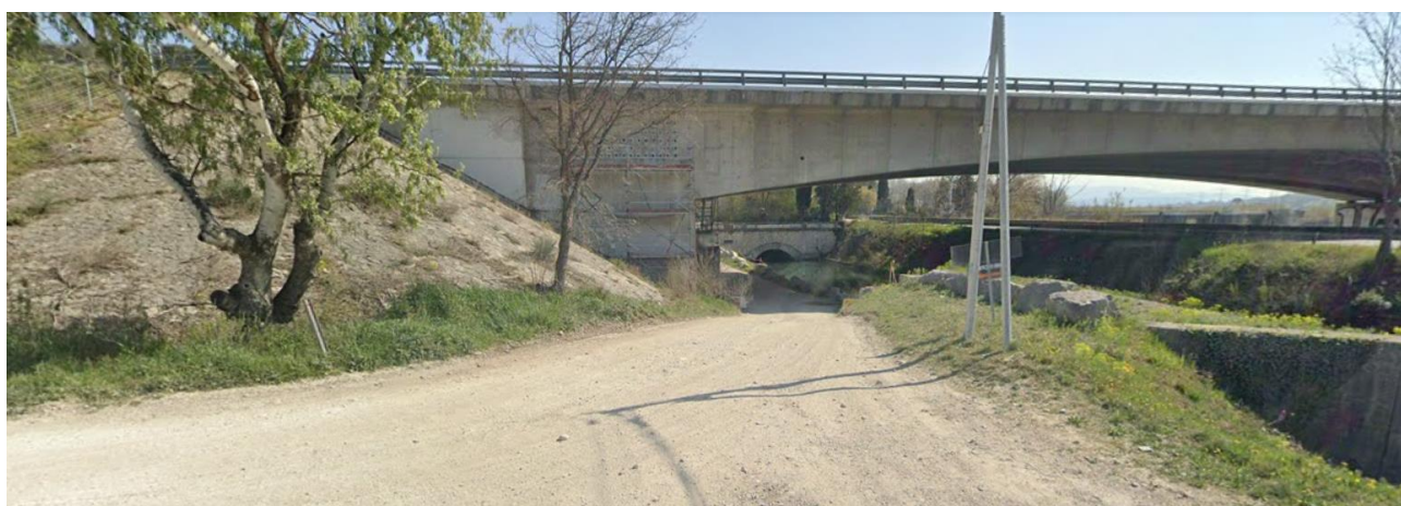
Figure 9 : Prise de vue en direction du site classé depuis la piste des travaux à l’aval du pont de l’autoroute (Source : GOOGLE EARTH )
