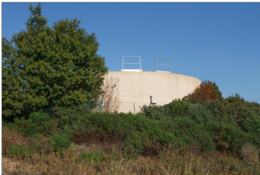
Réservoir d'eau situé en partie ouest du site
