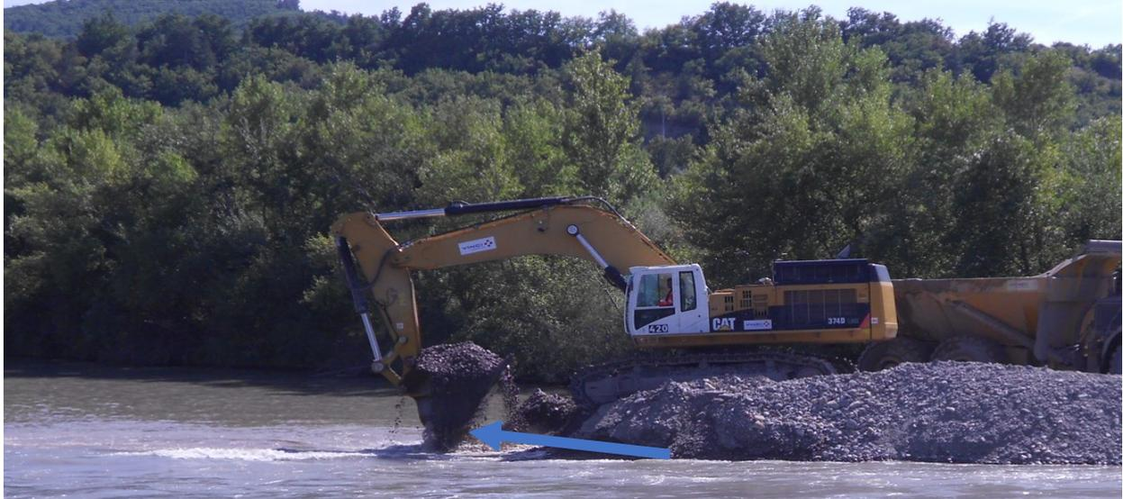
**Figure 42 : Pelle procédant au retrait du merlon d'aval vers l'amont en 2016 (une revanche sera maintenue en rivière en 2025 pour éviter de plonger le godet en Durance)**
