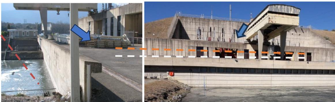
**Figure 13 : Cotes d'inondabilité et risque de submersion (par au-dessus) symbolisé par la flèche bleue**
