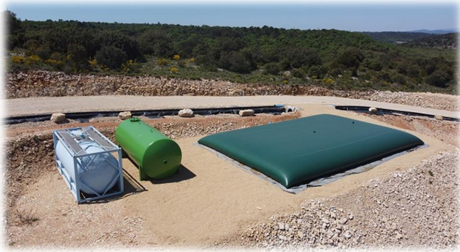
Bâche incendie 200 m 3
