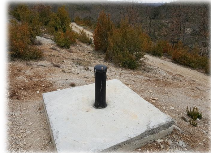
Piézomètres (eaux souterraines)
