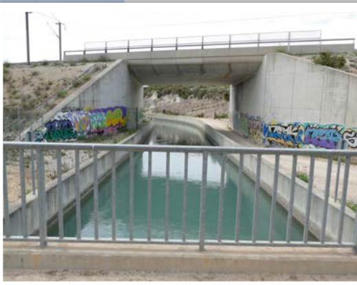
Passage du canal de Marseille sous la voie ferrée et portail (rive gauche) empêchant le passage de la faune sauvage © Nicolas FUENTO
