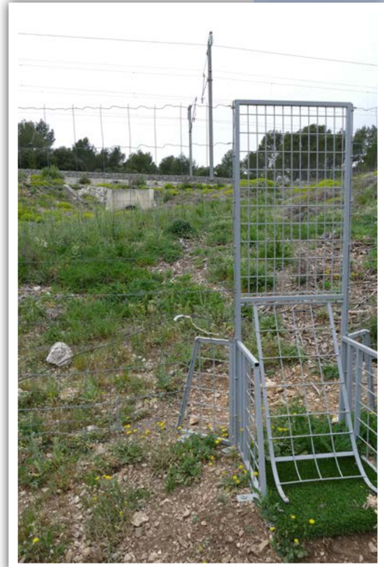
Échappatoire à grande faune observée au niveau de l'ouvrage © Nicolas FUENTO
