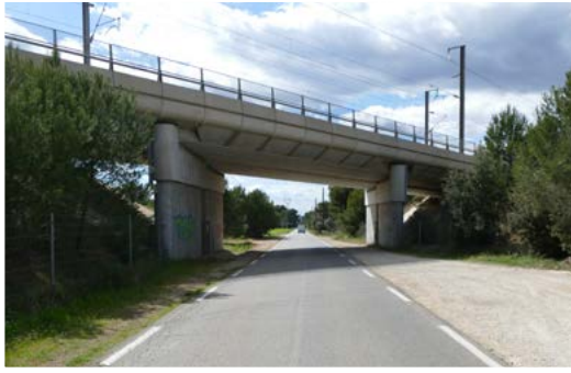
Pont de la RD17 sous la voie ferrée © Nicolas FUENTO
