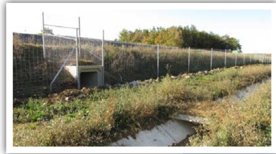
Passage inférieur parfaitement encadré par le grillage permettant de guider la faune vers les entrées © COSEA
