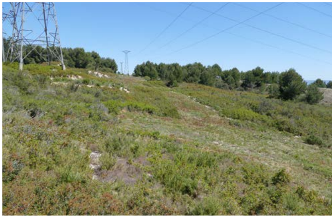
Croisement de lignes électriques sur l'espace naturel de la Sambre © Nicolas FUENTO
