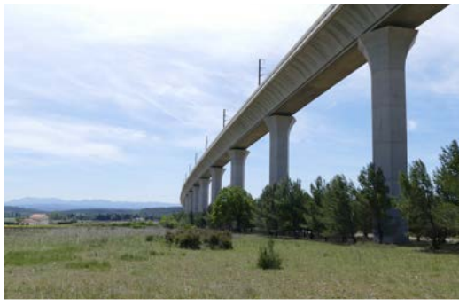
Viaduc des Pontails à Ventabren © Nicolas FUENTO
