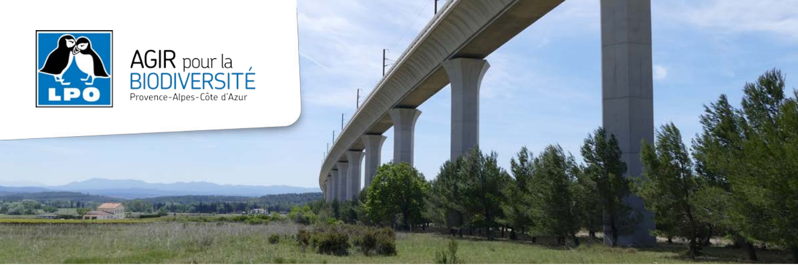
Viaduc des Pontails à Ventabren © Nicolas FUENTO
