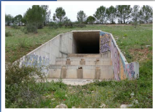
Triple seuil observé sur l'ouvrage n°③ © Nicolas Fuento
