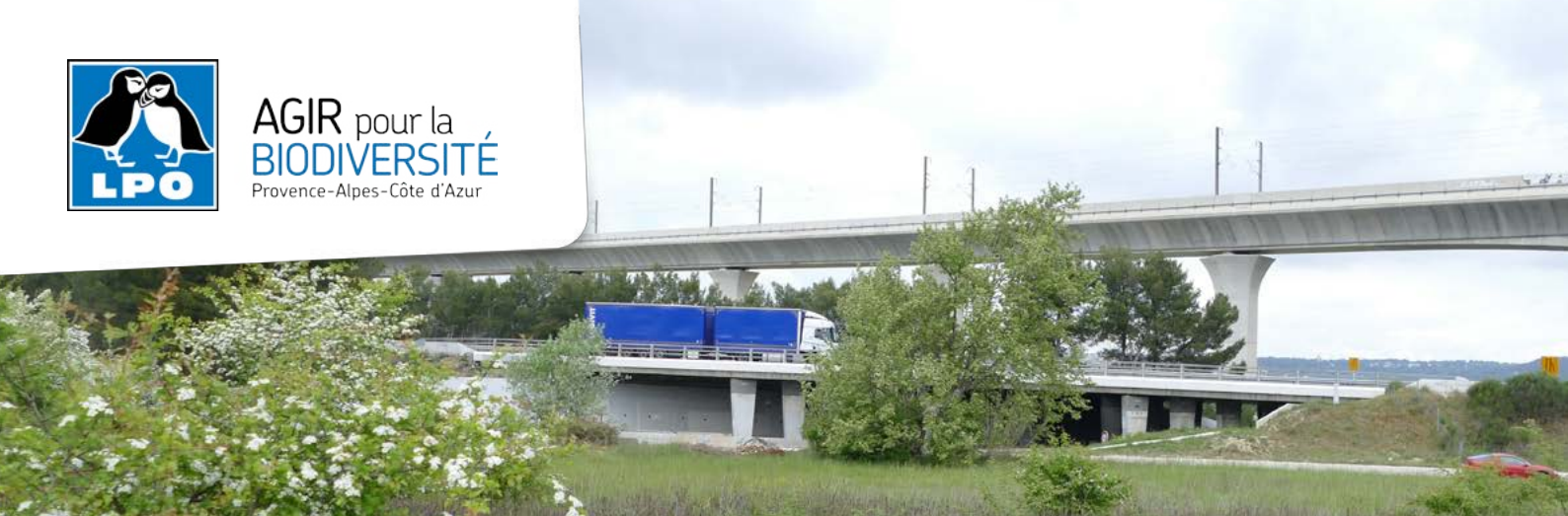
Le passage de la A8 sur la D10 et sous la voie ferrée aux Pontails © Nicolas FUENTO
