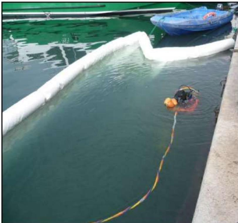
Figure 11. Utilisation d'un filet anti-MES similaire lors des travaux de réhabilitation des quais du port de St-Tropez ICTP 2011
