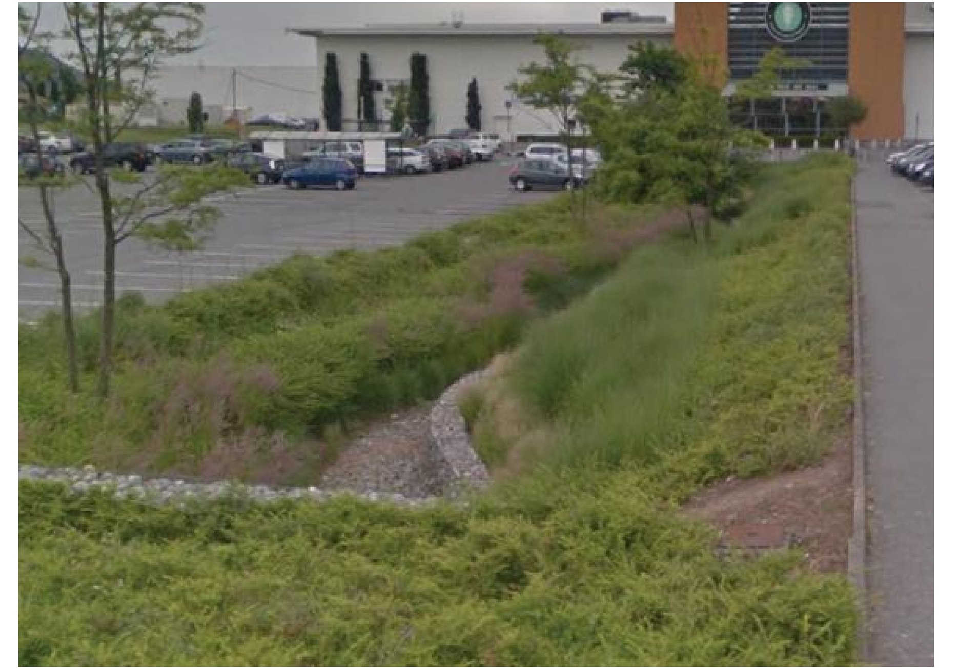
GESTION DES EAUX DE PLUIE SUR SITE
