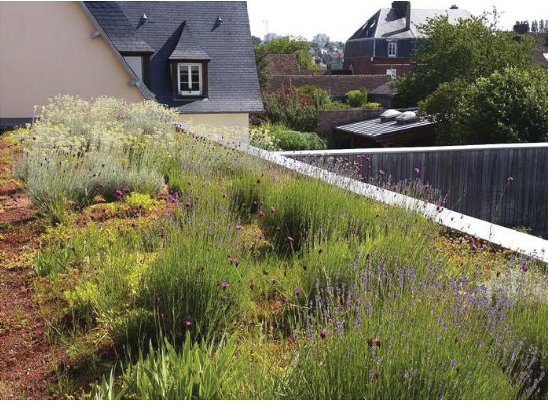
VÉGÉTALISATION SEMI-INTENSIVE DES TOITURES
