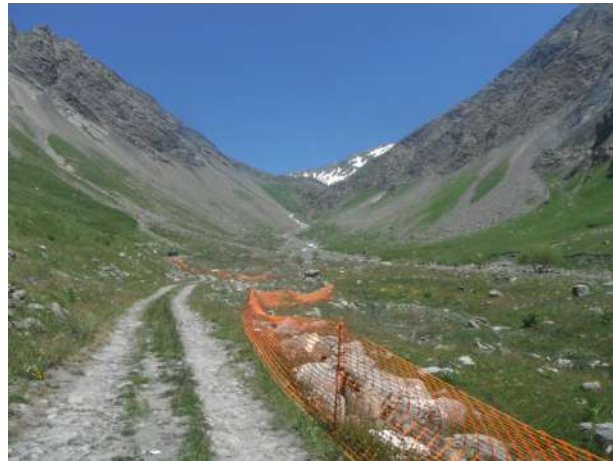
Exemple de mise en défens des abords d'un cours d'eau pour éviter toute dérive du futur chantier
