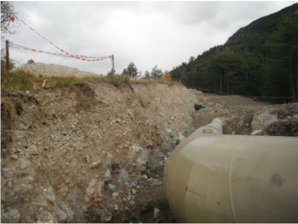
Exemple de balisage simple de chantier
