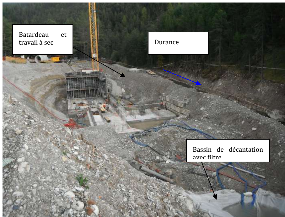
Photo GAY Environnement –chantier du Fontenil (05)
