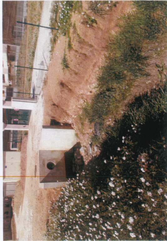
8 - Buse Ø400 et cadre / ruisseau Pas de Redon
