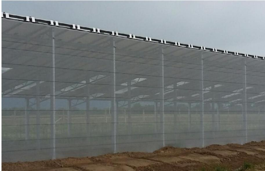
Les eaux pluviales seront récupérées via des chéneaux et acheminées vers un bassin de rétention (voir implantation sur le plan PC2)
