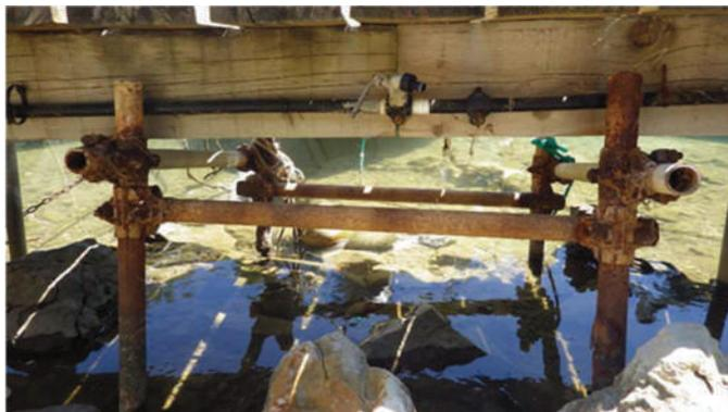
*Photographie 16 : Tubes d'échafaudage soutenant les pontons fixes*
