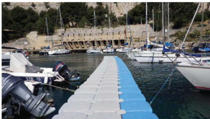
Photographie 18 : Ponton flottant modulaire sur la rive Est – Ponton dédié aux bateaux de passage Longue durée
