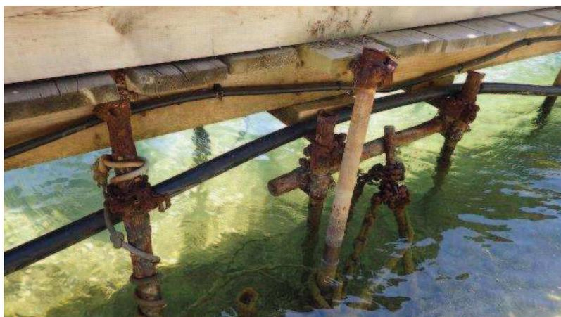
Photographie 13 : Réseaux aériens (AEP, EDF) sous ponton
