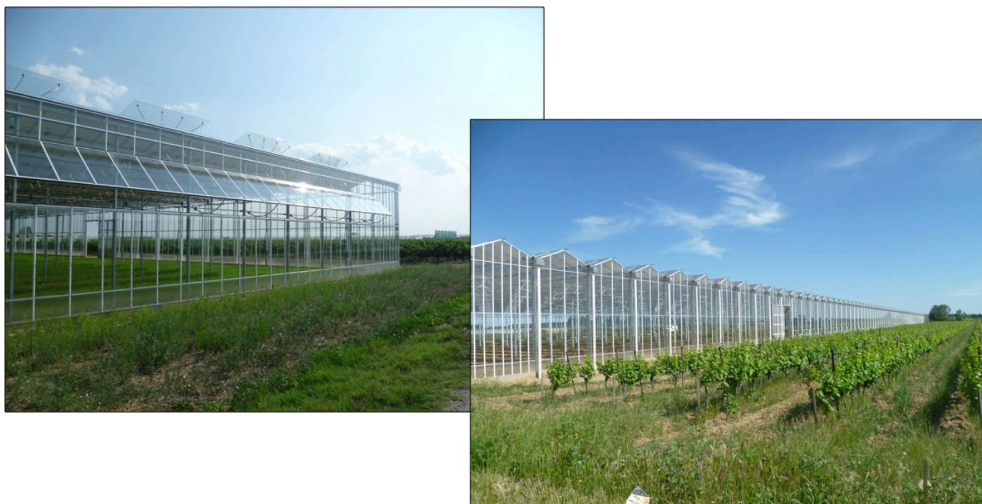
Quelques exemples de serres verres photovoltaïques : transparence et esthétique Source : REDEN Solar - Biogram 2018
