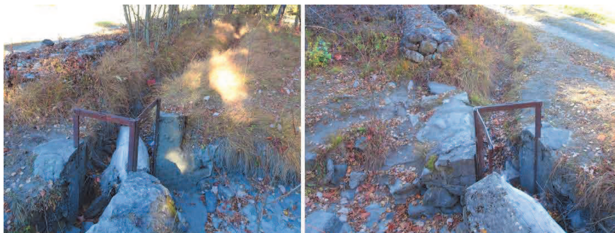
Fig. 45 : photos de la prise d'eau – tronc d'arbre présent et absence d'obturateurs
