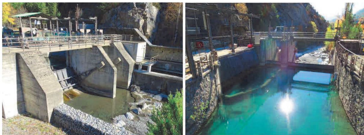
Fig. 48 : photographies de la prise d'eau de Pallon, depuis l'aval (à gauche) et depuis l'amont (à droite)
