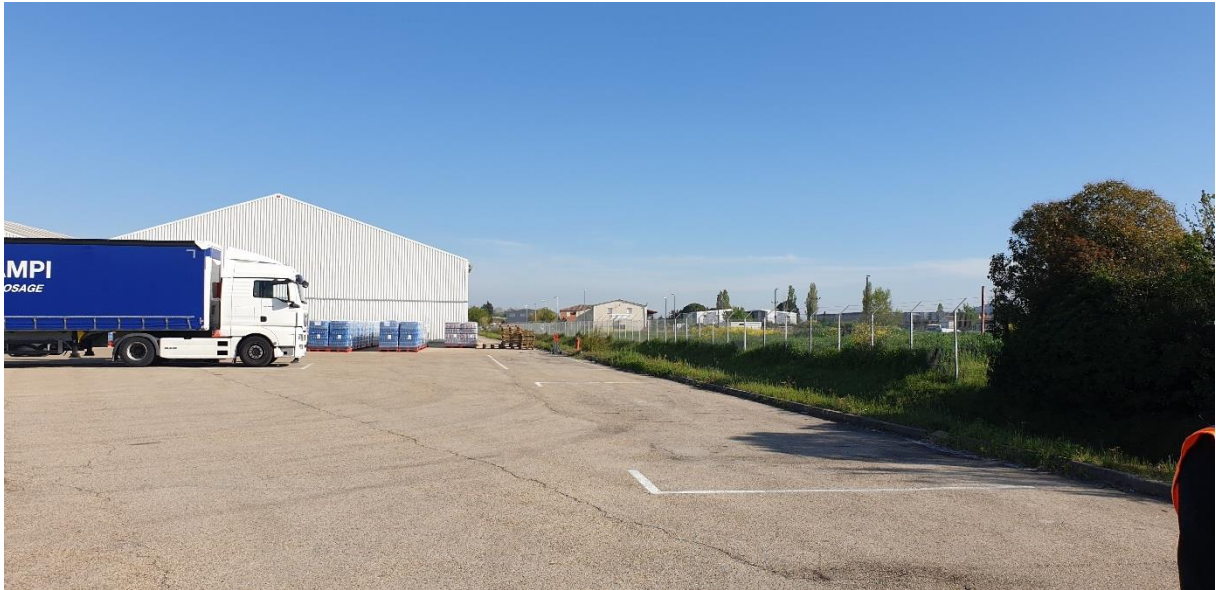
Photo 5 prise depuis l'intérieur du site :
