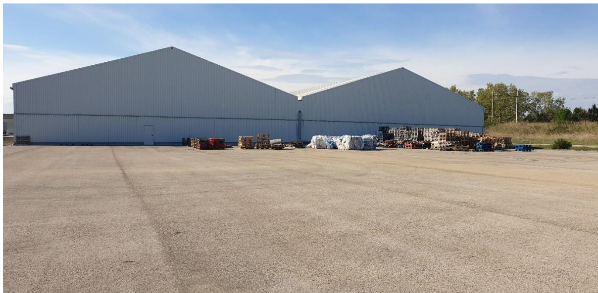
Photo 7 prise depuis l'intérieur du site :
