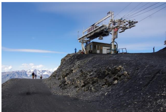
Photo 62 Des perceptions anthropisées par la gare de départ du télésiège du glacier de la Girose, effet accentué par les terrassements anguleux
