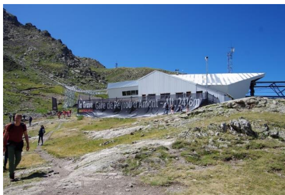
Photo 39 La gare de Peyrou d'Amont, sa blancheur et son architecture en angles marqués
