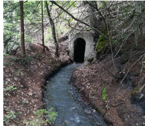
Entrée du tunnel
