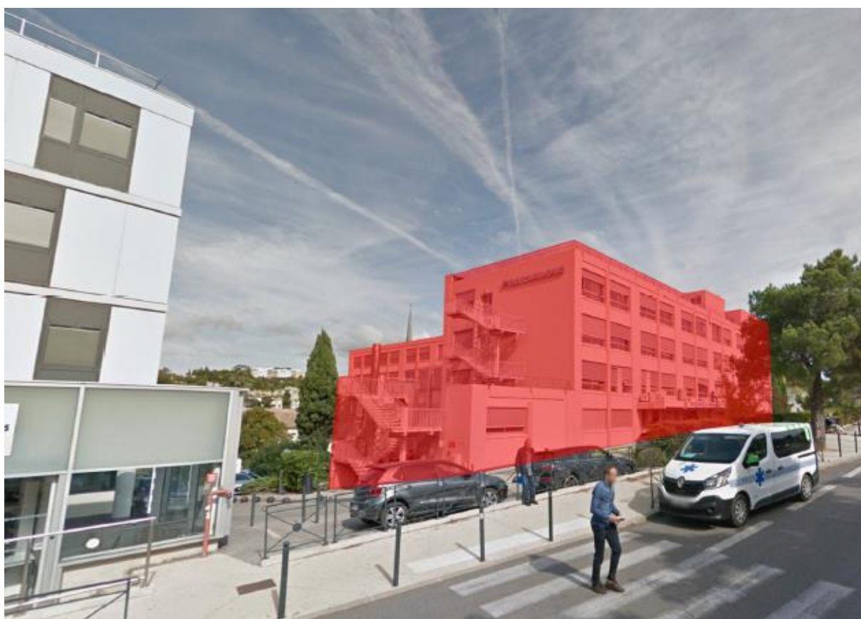
Vue aérienne et vue proche - 2020
