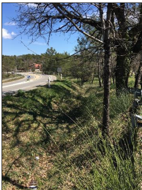
Photographie n°1 : Fossé le long de la RD63
