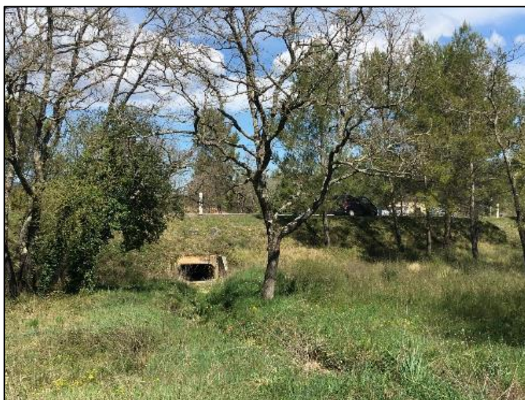
Photographie n°2 : Exutoire du bassin de rétention sous la RD43
