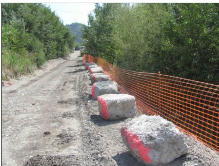
Exemple de mise en place d'un balisage de stations d'espèce patrimoniale et d'un dispositif prévenant contre la sortie accidentelle d'engins de la zone d'emprise
