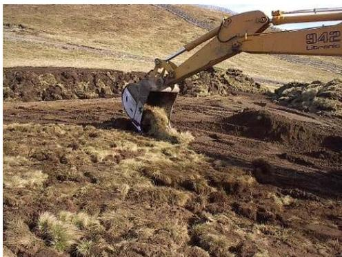
**Photo 12** Exemple de remise en place de mottes à la pelle mécanique
