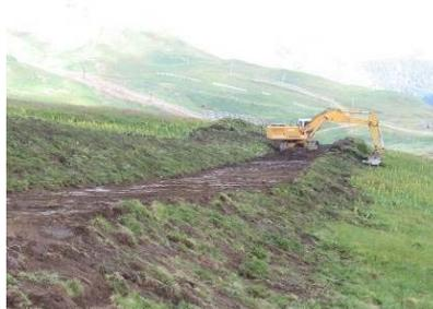
**Photo 11** Exemple de stockage de mottes à la pelle mécanique en bordure d'emprise
