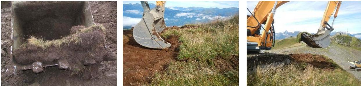
**Photo 10** Exemple de déplaçage de mottes à la pelle mécanique et godet « classique »
