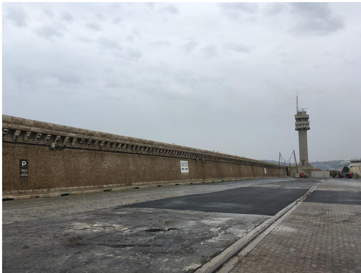
Figure 3. Vue du quai du poste 122 vers le Nord-Ouest
