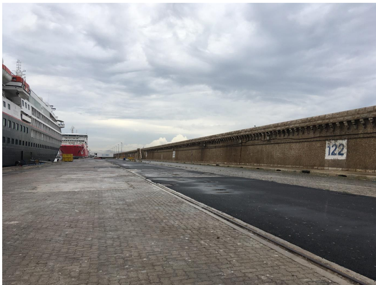
Figure 1. Vue du quai du poste 122 vers le Sud-Est
