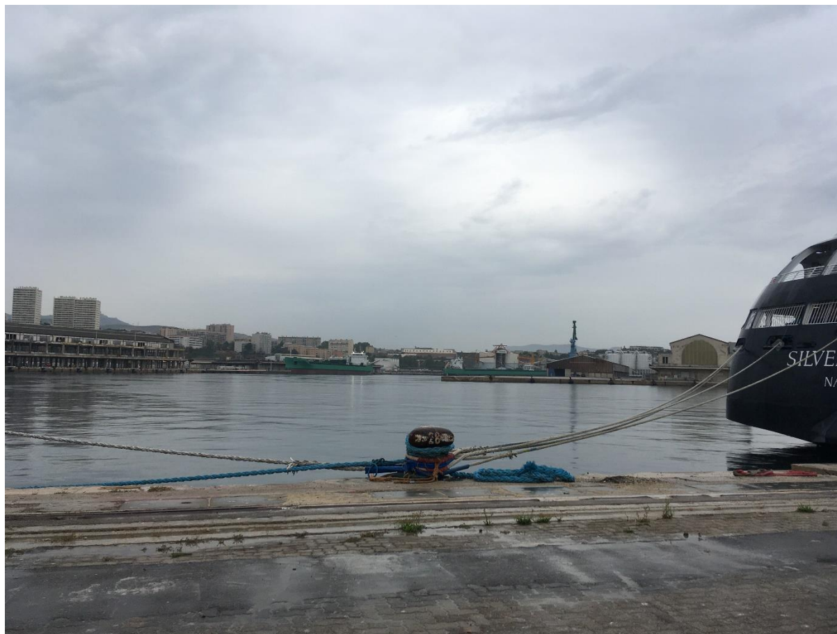
Figure 2. Vue du bassin du Président Wilson depuis le poste 122
