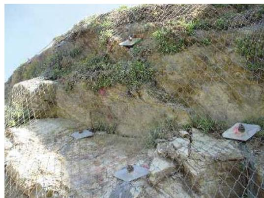
Treillis TECCO® en fils d'acier ultra-résistants avec extrémités nouées.
