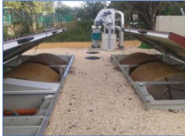
FIGURE 1 : EXEMPLE D'INSTALLATION BIODISQUES
