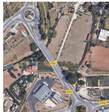
RD26 entre RD11 et avenue J. Monnet : une section à trois voies de circulation, intégrant des entrées à deux voies sur les giratoires (une voie en sortie)
