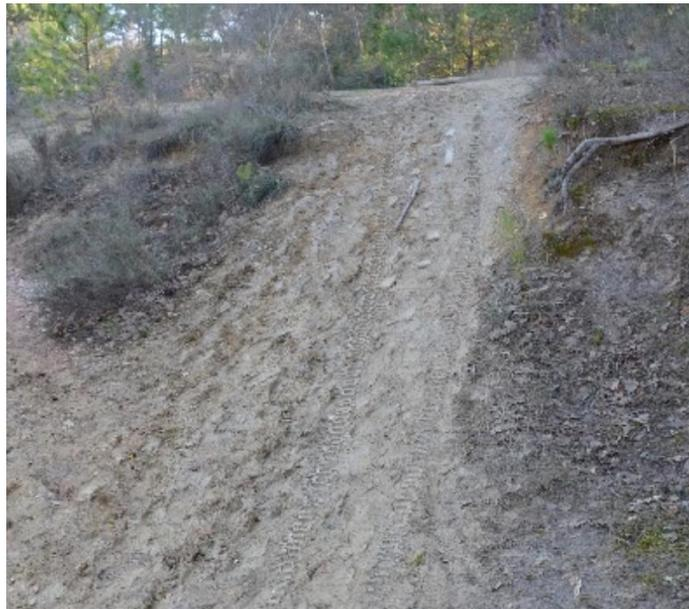
Figure 37 : Erosion progressive témoignant du passage répété de 2 roues
