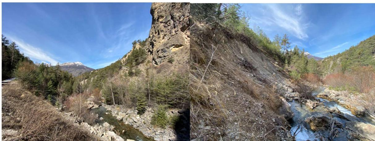
Figure 35 : Aperçu de la zone d'érosion de la berge à reprendre
