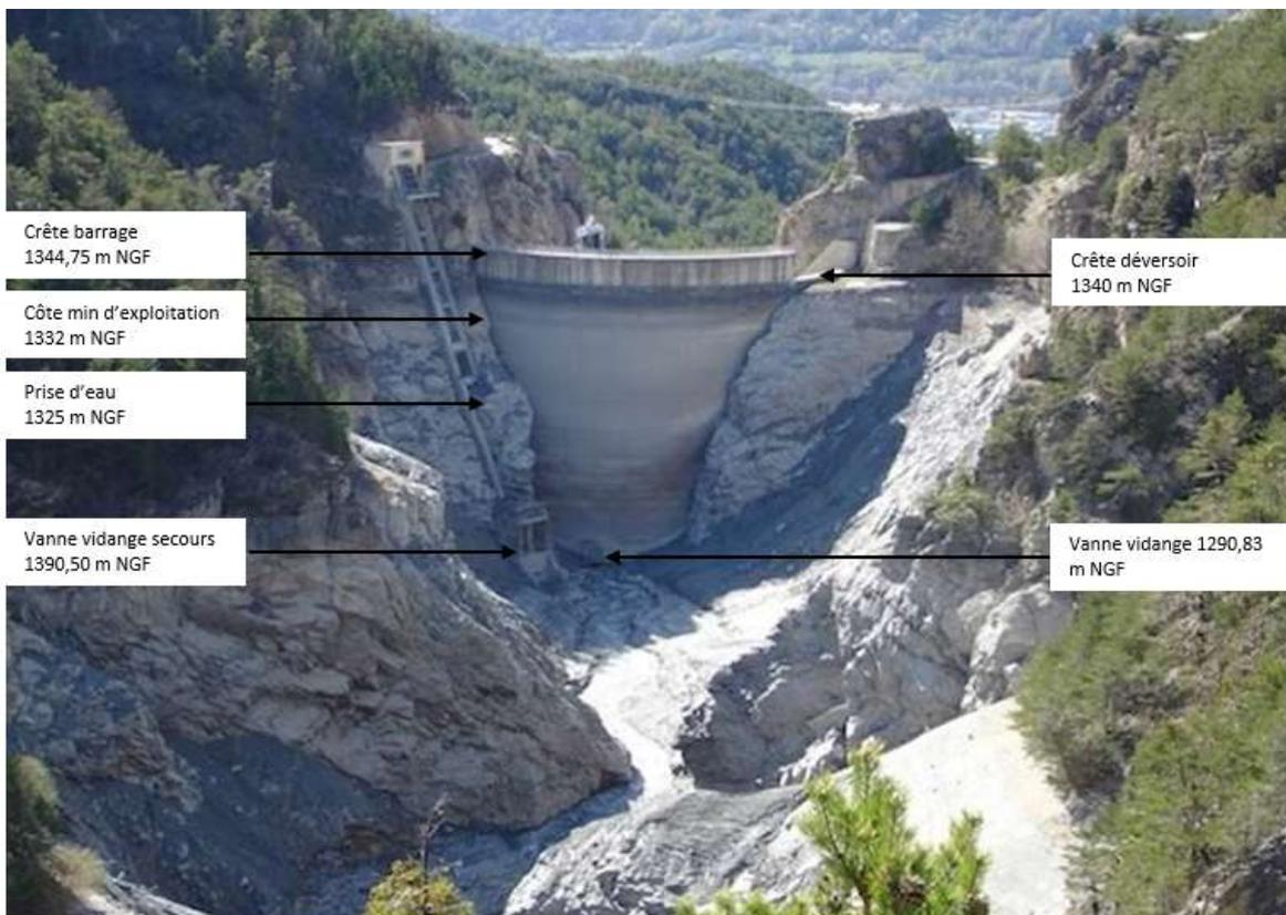
**Figure 21 : Présentation du barrage (photographie du parement amont du barrage)**
